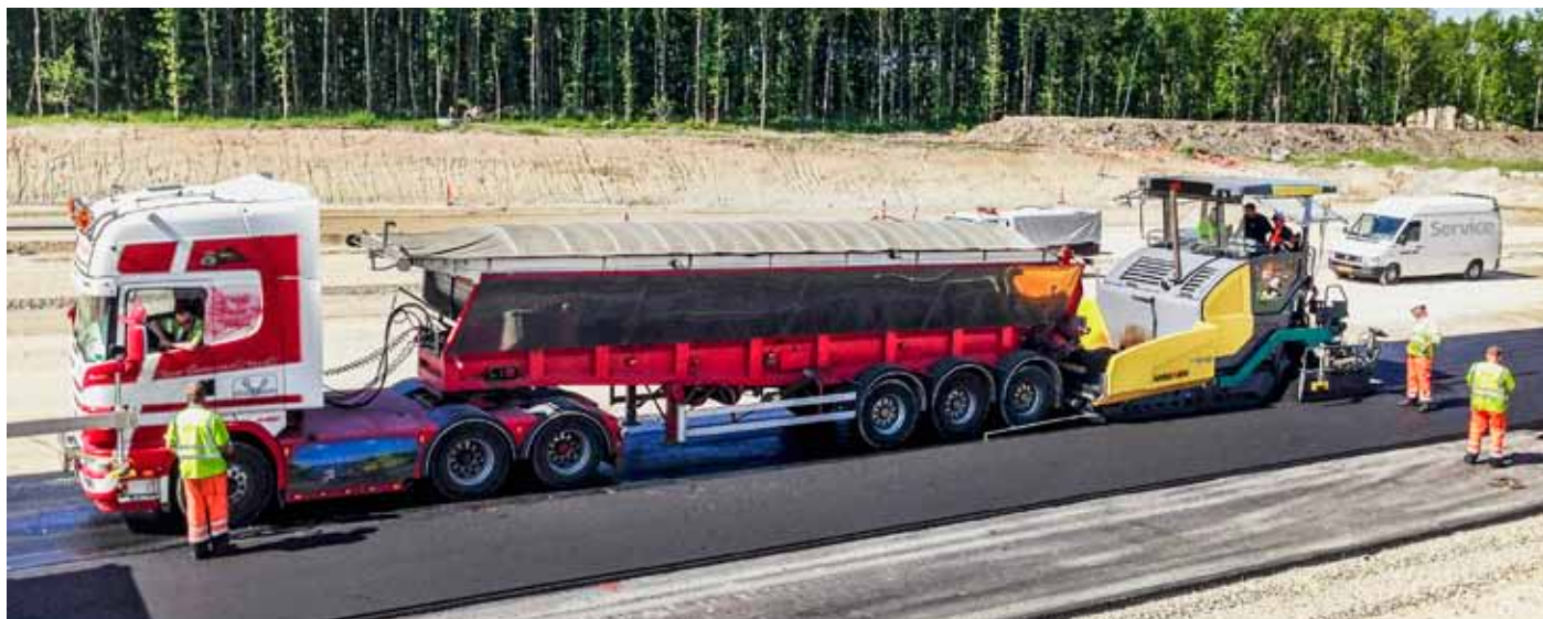
Zapojení finišeru AFT 900-3 do opravy silničního svršku
