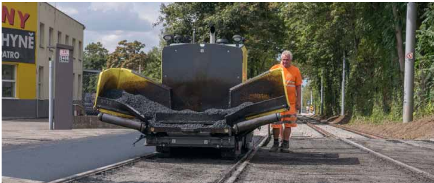
Poprvé byl asfaltový finišer Ammann AFT 300-2 nasazen v centru Brna při obnově tramvajové tratě
